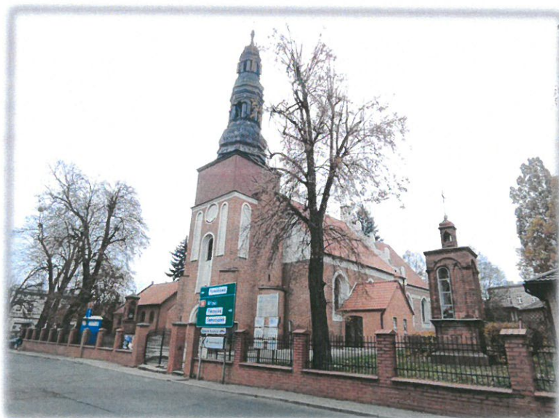
Ryc. 4 Kościół pw. św. Andrzeja w Koronowie
