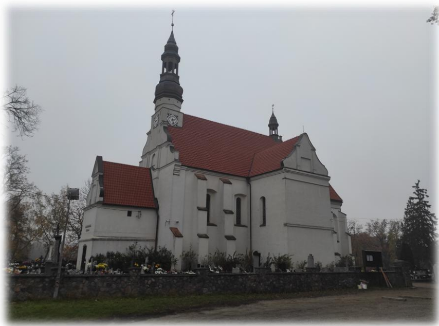
Ryc. 6 Kościół pw. św. Trójcy w Byszewie
