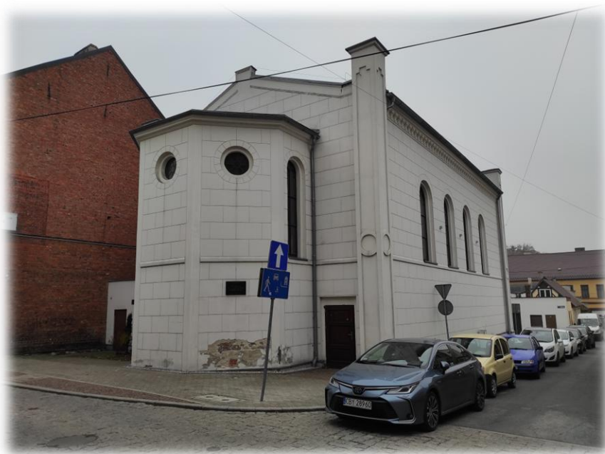
Ryc. 5 Synagoga w Koronowie
