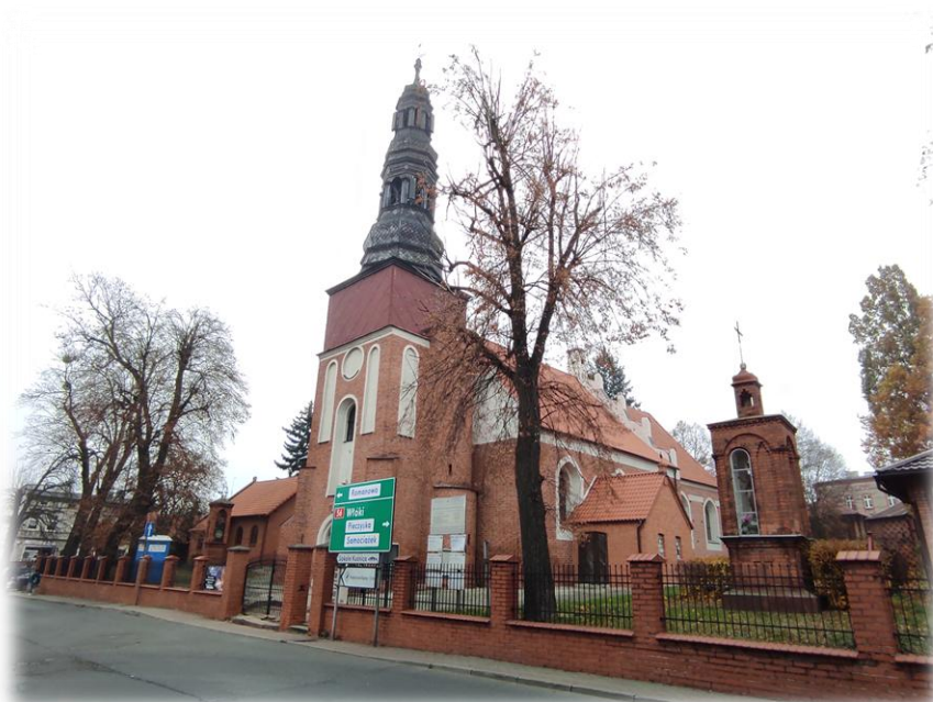
Ryc. 4 Kościół pw. św. Andrzeja w Koronowie
