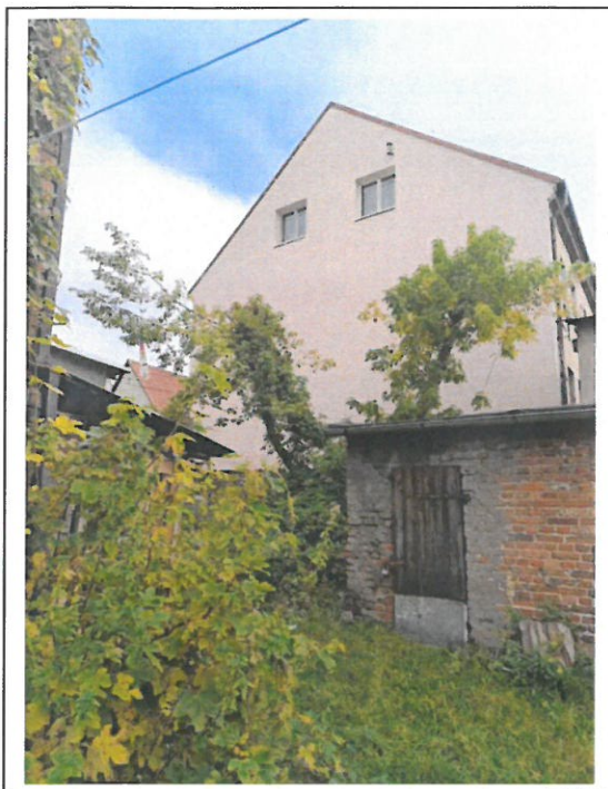
Fot. Ściana szczytowa kamienicy, ul. Wodna 6 w Koronowie
